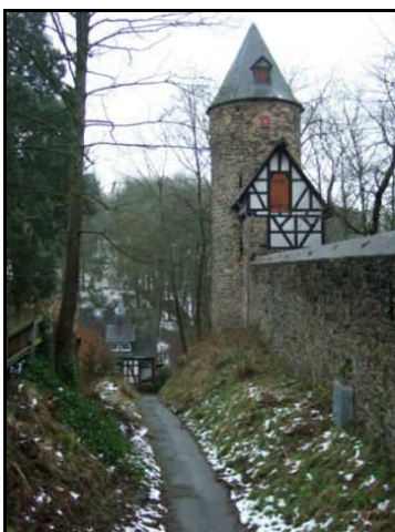
Burggraben vor der Südmauer
